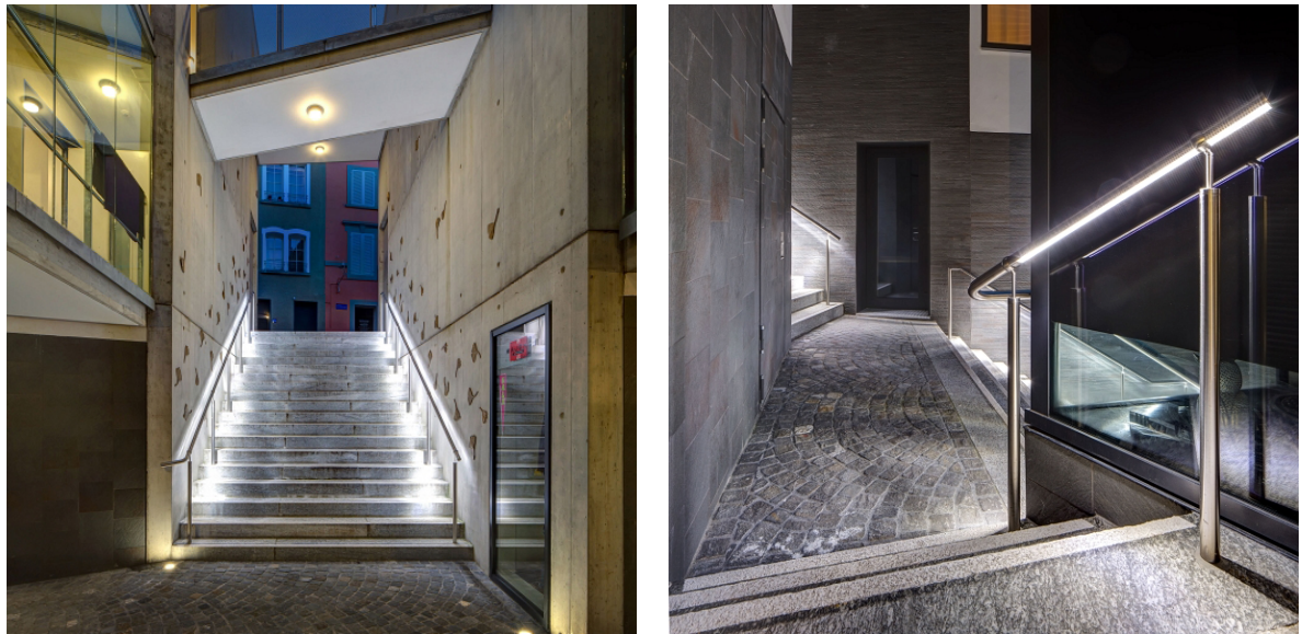
Figure 18 : Dans le quartier du Rôtillon à Lausanne, les escaliers sont éclairés en sus par des LED dissimulées dans la main courante. Les différentes marches sont munies d'une bande blanche antidérapante qui accroît le contraste visuel (source : Ville de Lausanne 15 ).
