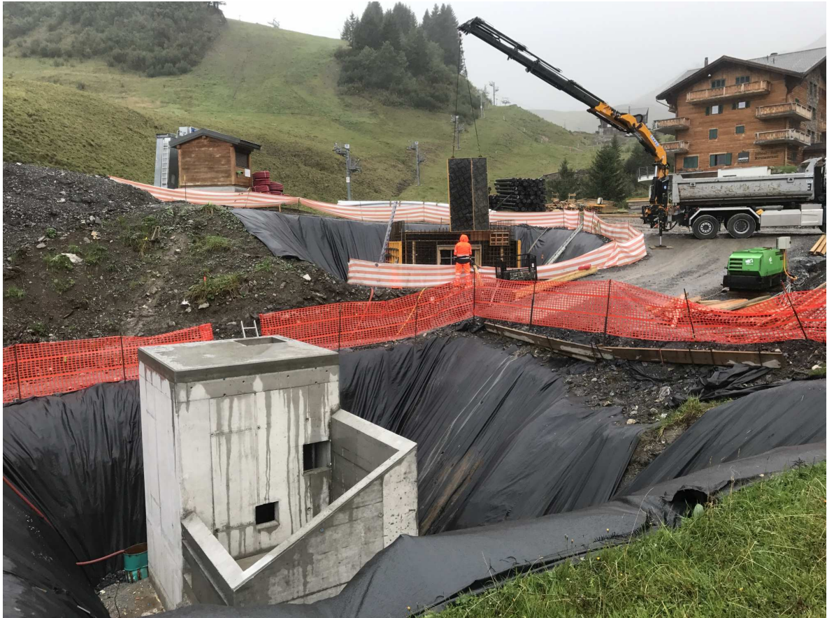
Aux Crosets, un captage et une station de pompage permettront de prélever l'eau dans le torrent de Naulaz. © Le Nouvelliste
