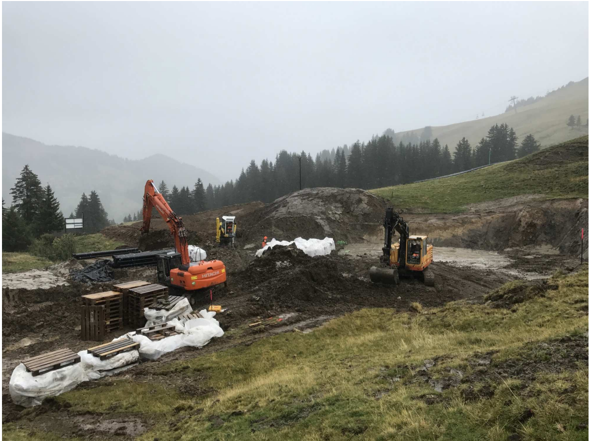
A Planchaux, le lac artificiel ne sera mis en chantier que l'an prochain. Mais les travaux préparatoires ont déjà commencé, notamment les terrassements pour la station de pompage principale. © Le Nouvelliste
